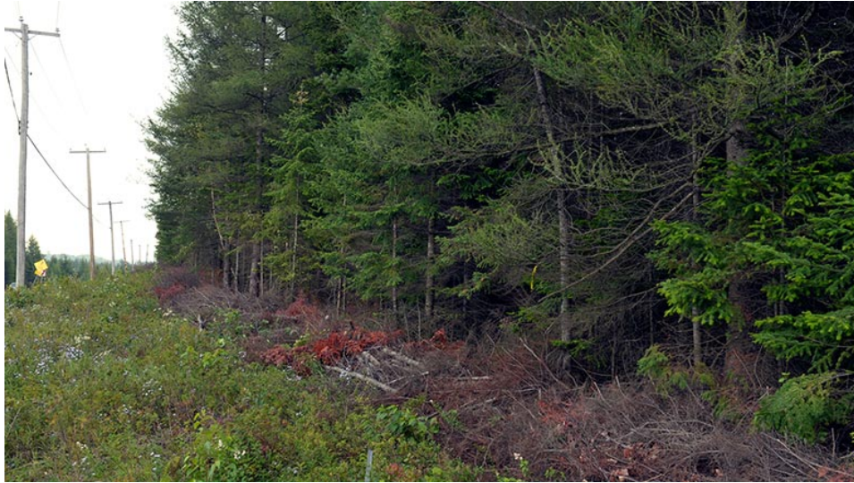
Chaque année, Hydro-Québec déboise plus de 20 000 portées de ligne (une portée est la portion d'une ligne aérienne qui relie deux poteaux consécutifs).
