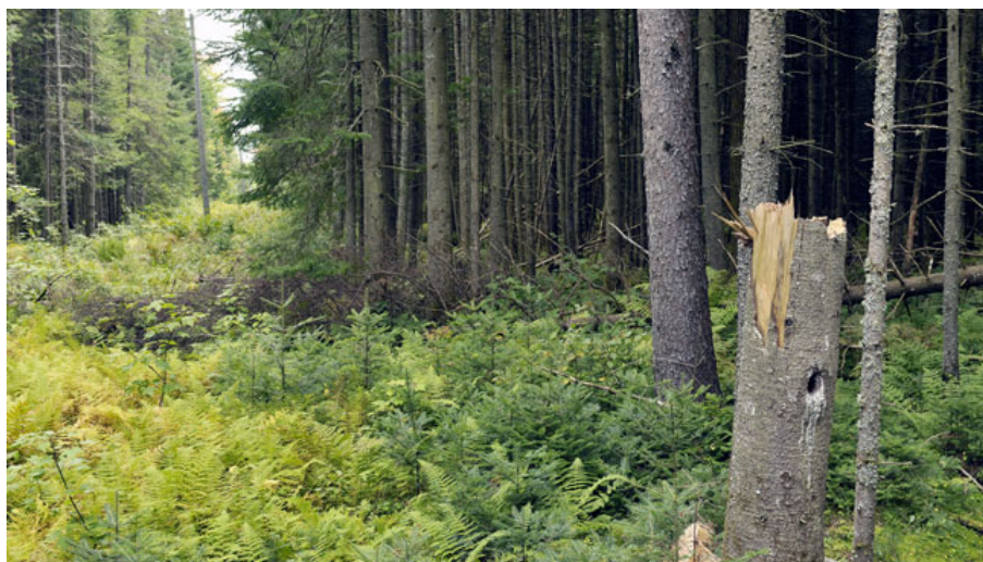
Conservation d'un petit chicot de sapin après un travail de déboisement sous une ligne de distribution.
